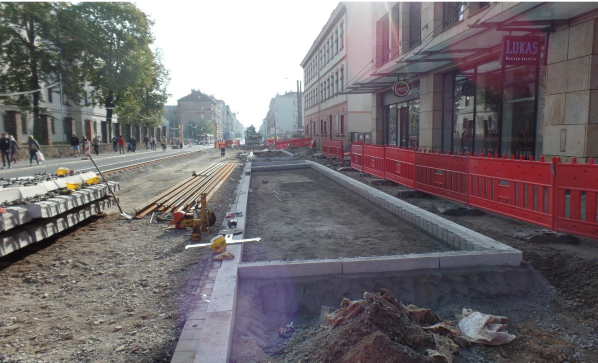
Abschnitt 6.1 Faradaystraße – S-Bahn Brücke
