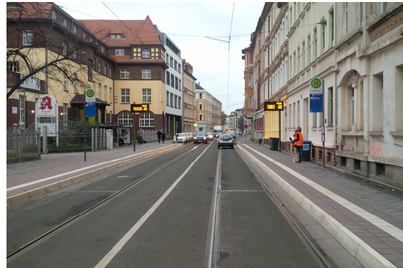
Barrierefreies Haltestellenkap mit überfahrbarem Radweg – Beispiel Haltestelle Diakonissenkrankenhaus
